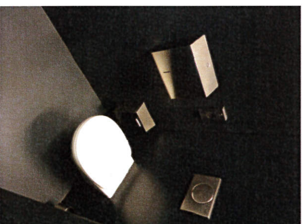
Fot. 32. TOALETY DAMSKA DLA KLIENTÓW W BUFECE, pomieszczenie a.p. 0.2.05
