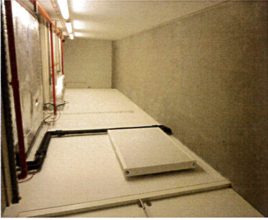
Fot. 2. KORYTARZ DOSTAWY, POZIOM P-2 pom. a.p-2.2.K17
