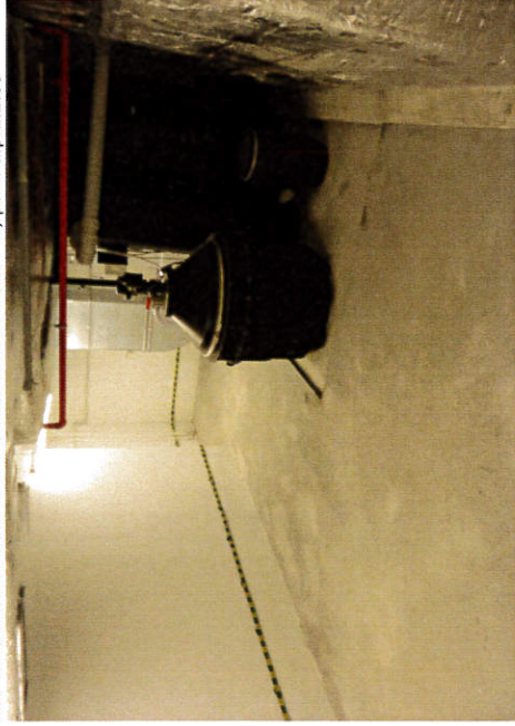
Fot. 1. MAGAZYN ORAZ POMIESZCZENIE SEPARATORA P-2, pom. a.p-2.2.58
