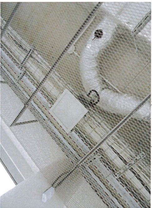
Fot. 29. OŚWIETLENIE I SUFIT W BUFECE, pomieszczenie a.p. 0.1.03
