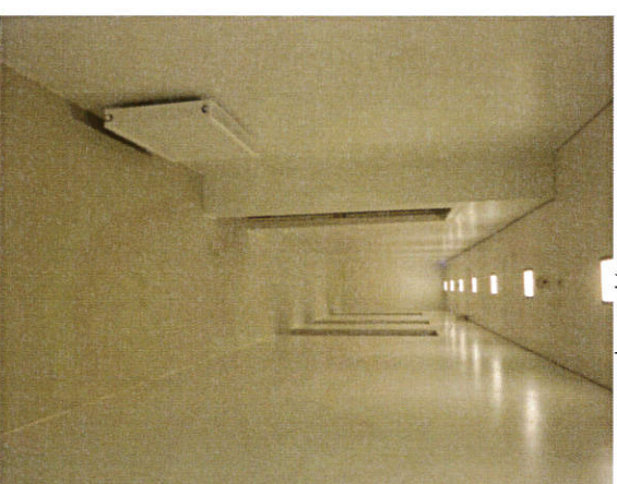
Fot. 8. KORYTARZ POZIOM P-1, pom. a.p-1.4.K3
