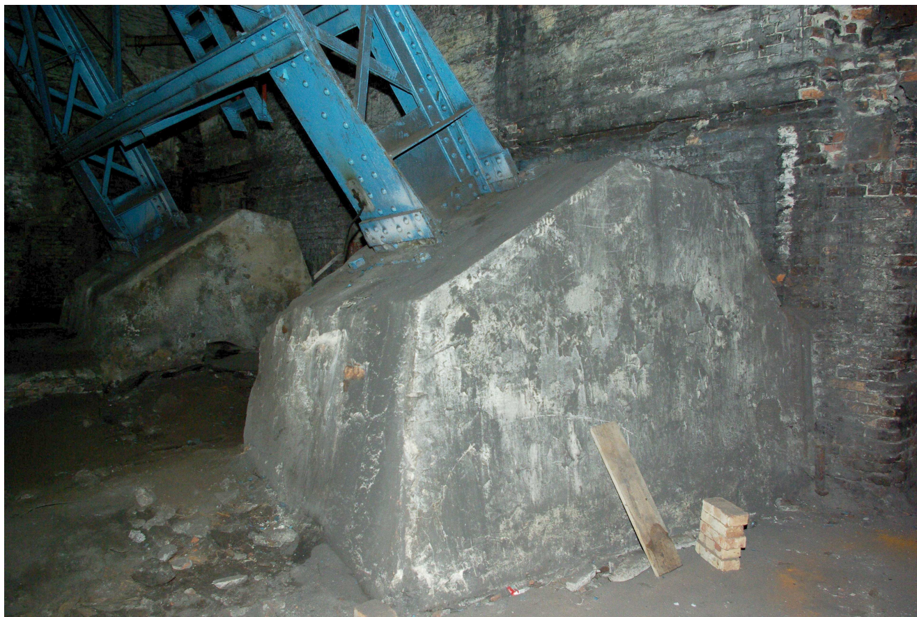
Fot. 12, 13 Fundamenty zastrzału
