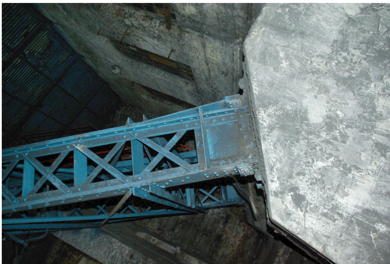
Fot. 12, 13 Fundamenty zastrzału
