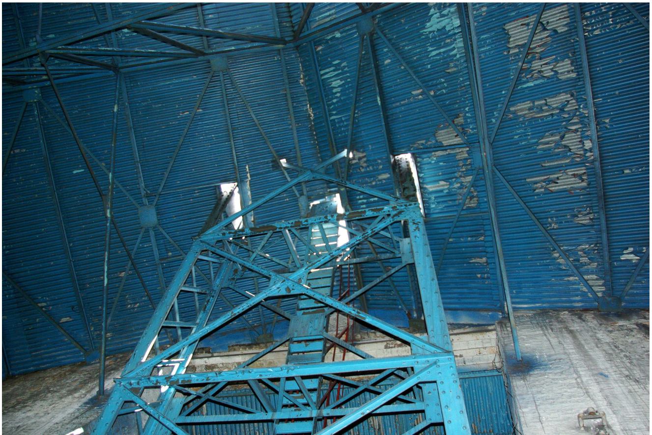
Fot. 15 Szczegół przejścia zastrzału przez dach
