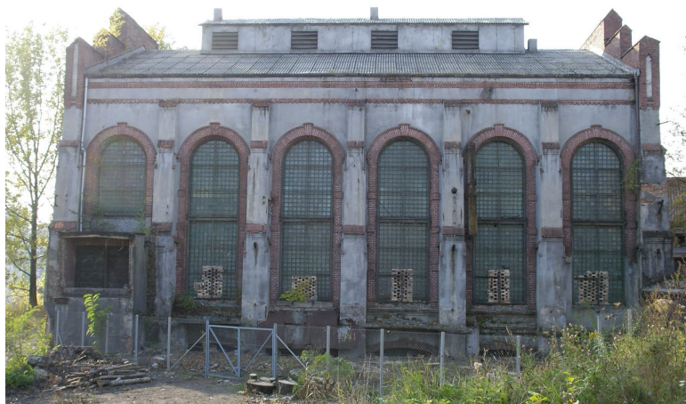
Fot. 2/32 Elewacja południowa.
