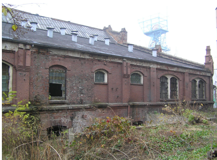
Fot. 4/14 Elewacja północna. Na drugim planie widoczny szyb Warszawa.
