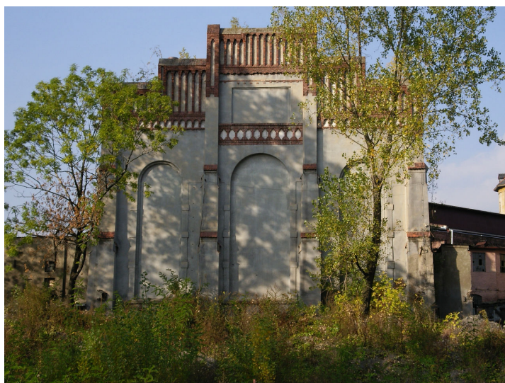
Fot. 3/32 Elewacja zachodnia
