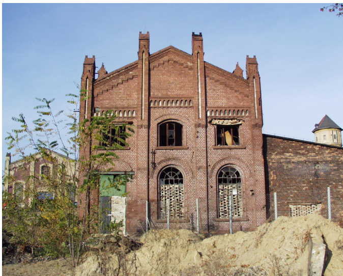
Fot. 3/46 Elewacja zachodnia.
