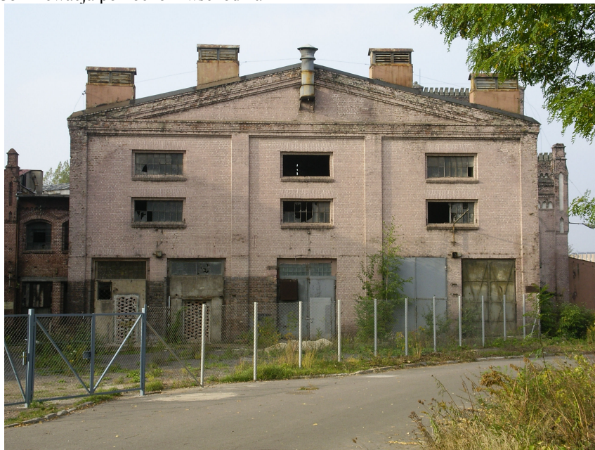
Fot. 1/35 Elewacja północno – wschodnia
