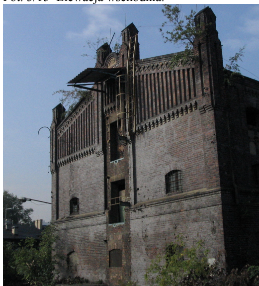
Fot. 4/15 Elewacja północna.
