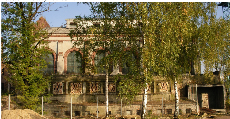
Fot. 4/32 Elewacja północna. Na drugim planie widoczny szyb Warszawa.
