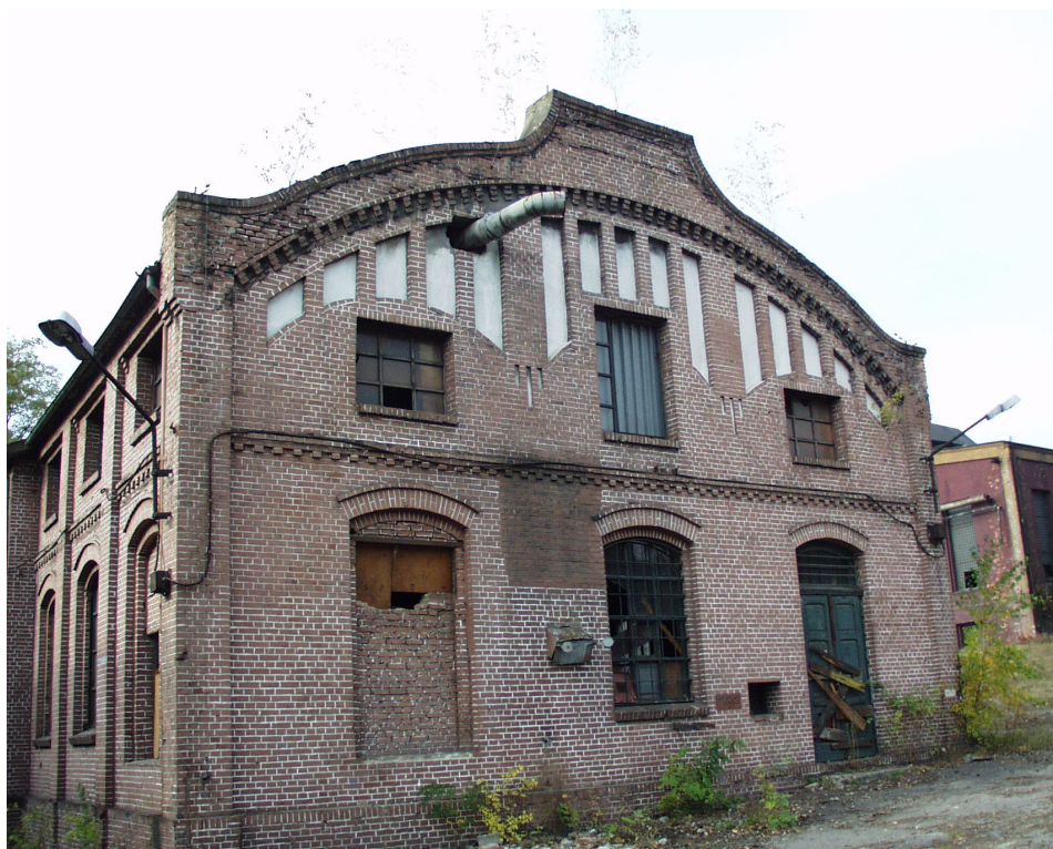
Fot. 4/18 Elewacja południowa , narożnik południowo - wschodni.
