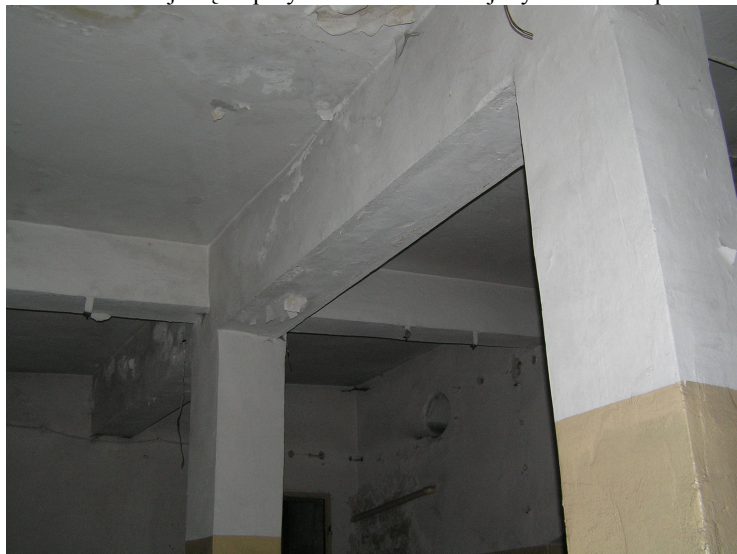
Fot.7/14 Strop żelbetowy w części dobudowanej.
