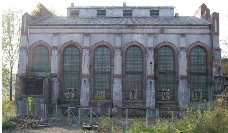
Fot. 3/32 Elewacja południowa.
