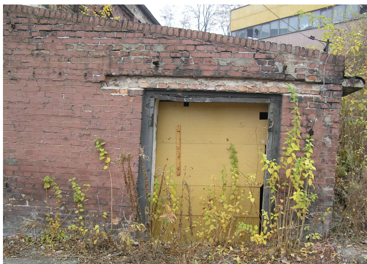
Fot. 5/14 Widok ścian w części dobudowanej.
