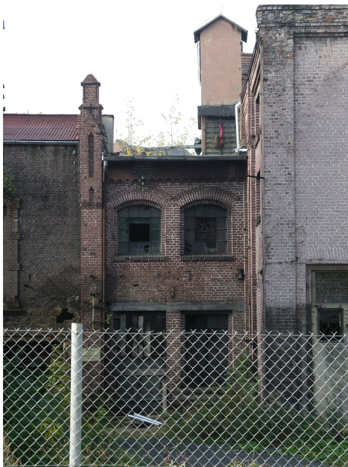
Fot. 4/35 Elewacja północno – zachodnia.
