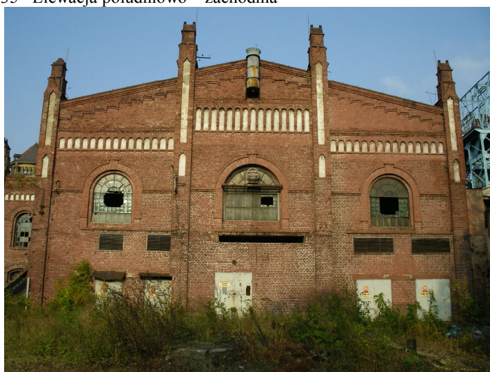
Fot. 3/35 Elewacja północno – wschodnia. Przewiązka między budynkiem dawnej siłowni energetycznej i budynkiem nadszybia szybu Bartosz.
