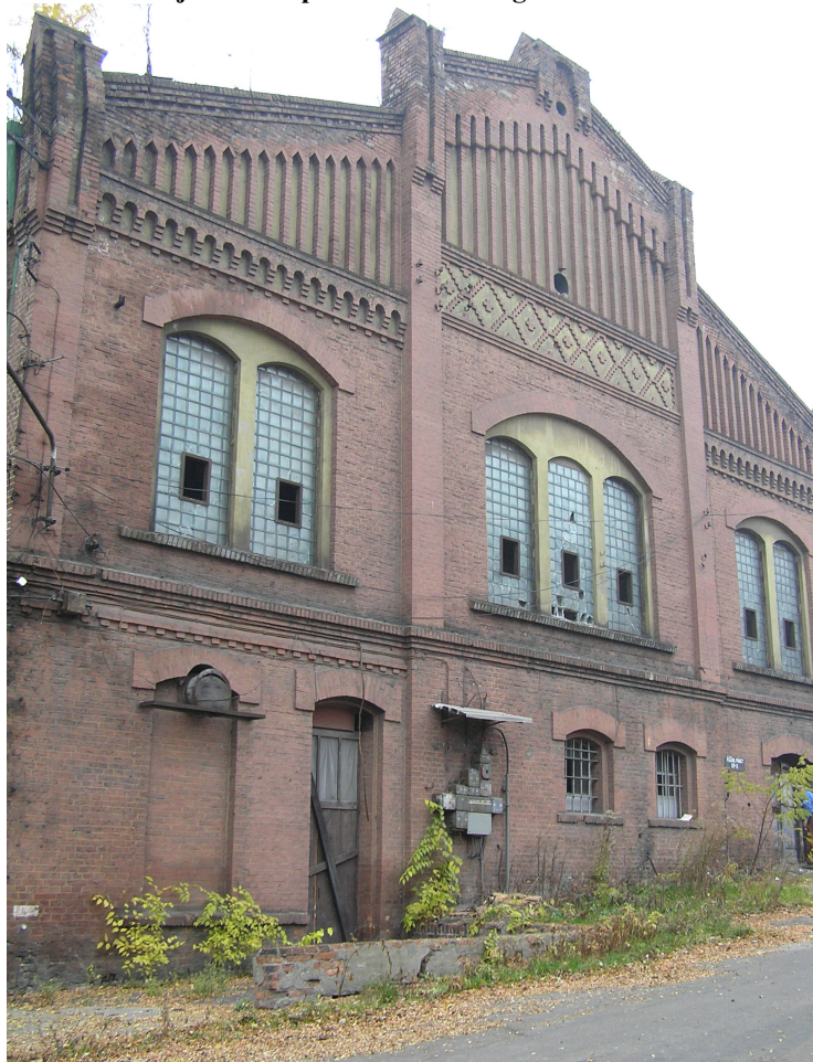
Fot.1/14 Elewacja wschodnia.
