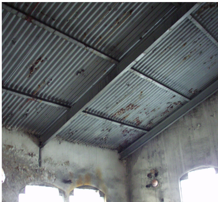
Fot.6/14 Konstrukcja dachu w części dobudowanej
