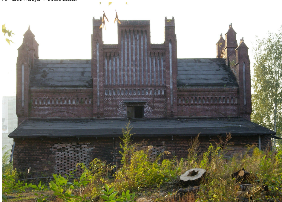
Fot. 1/46 Elewacja wschodnia.
