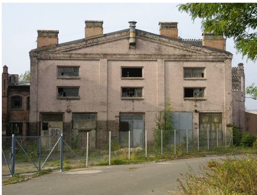
Fot. 2/35 Elewacja południowo – zachodnia
