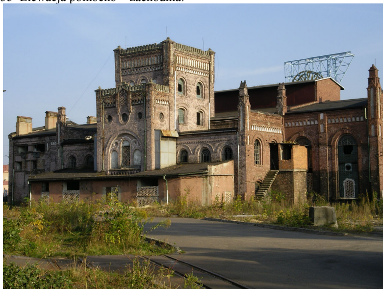
Elewacja południowo-wschodnia zasłonięta jest w całości budynkiem nadszybia wieży Bartosz.
