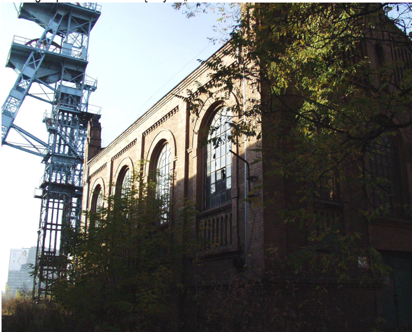
Fot. 3/8 Elewacja zachodnia
