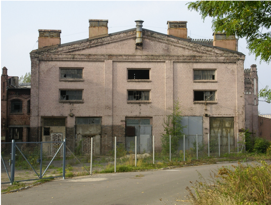
Fot. 2/35 Elewacja południowo – zachodnia
