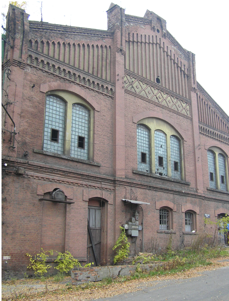
Fot.1/14 Elewacja wschodnia.
