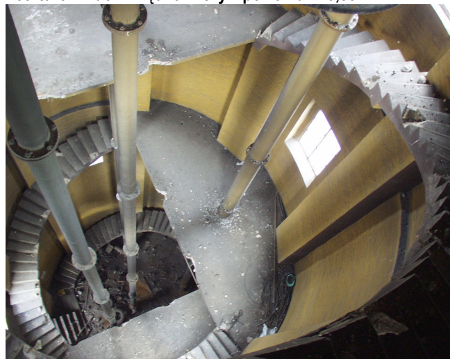
Fot. 3/78 Widok wnętrza wieży z poziomu +23,83 m.
