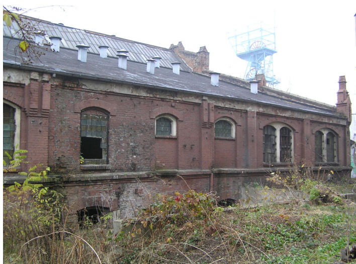
Fot. 4/14 Elewacja północna. Na drugim planie widoczny szysz Warszawa. Wiek budynku:
