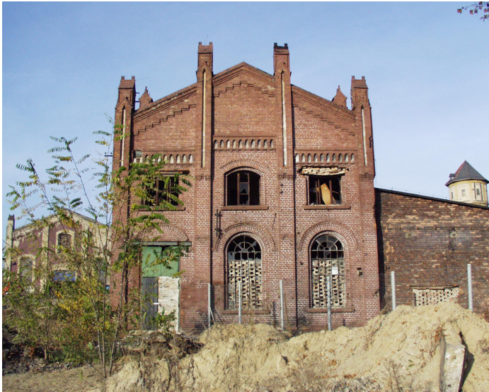
Fot. 3/46 Elewacja zachodnia.
