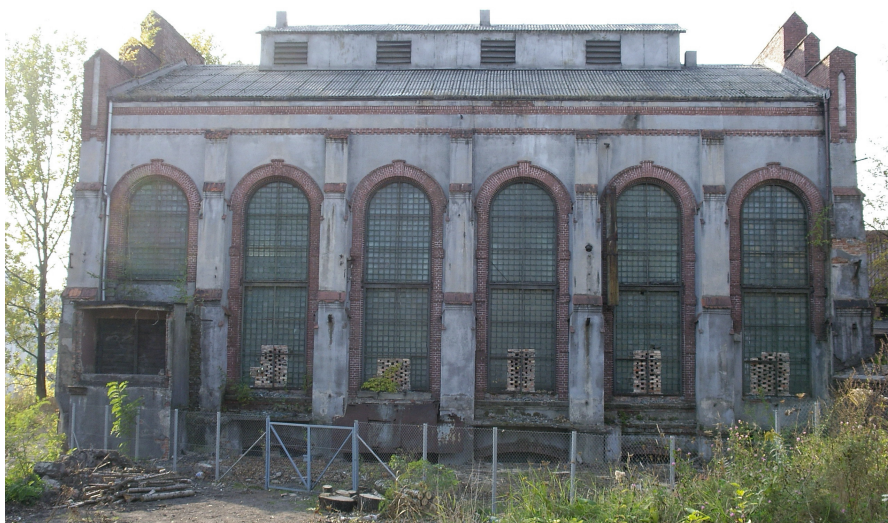
Fot. 3 Elewacja południowa.
