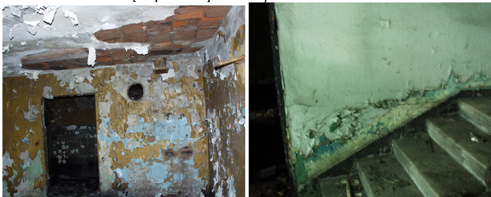
Fot. 5 Widok ścian w części piwnicznej dobudowy.
