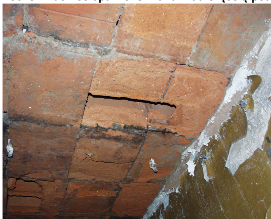
Fot. 6 Widok stropu Ackermana nad częścią podpiwniczoną dobudowy.
