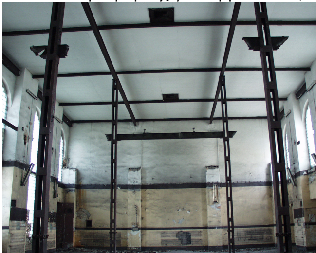
Fot. 8 Widok słupów podpierających strop poziomu +10,25.
