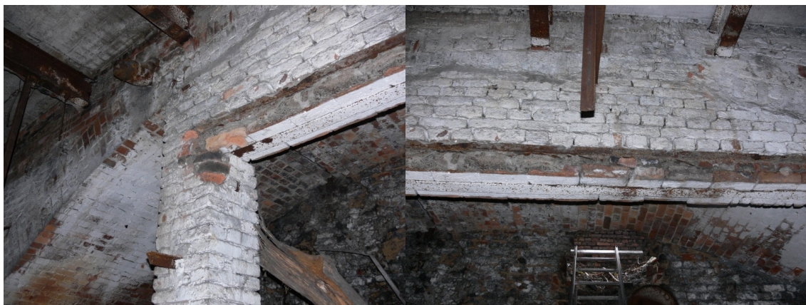
Fot. Ob-32/13,14 Widok wzmocnienia konstrukcji stropu nad piwnicą.
