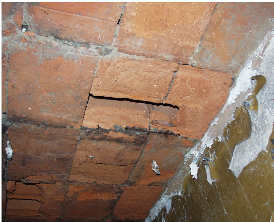
Fot. Ob-32/16 Widok konstrukcji stropu nad piwnicą w części dobudowanej (niższej). Widoczne pustaki stropu Ackermana.
