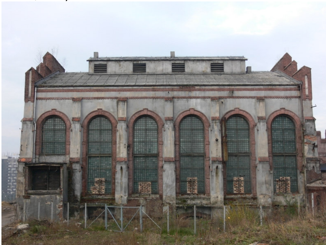
Fot. Ob-32/3 Elewacja wschodnia.
