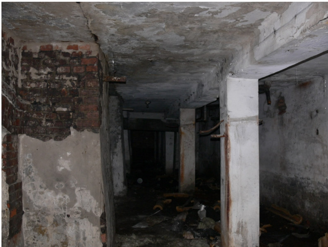
Fot. Ob-32/15 Widok konstrukcji stropu nad piwnicą w części dobudowanej (wyższej). Widoczne słupy i podciąg żelbetowy. Po lewej stronie murowana ściana części starszej obiektu.
