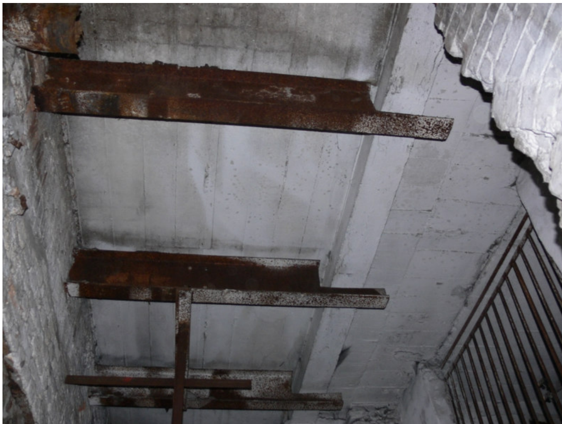
Fot. Ob-32/13,14 Widok wzmocnienia konstrukcji stropu nad piwnicą.
