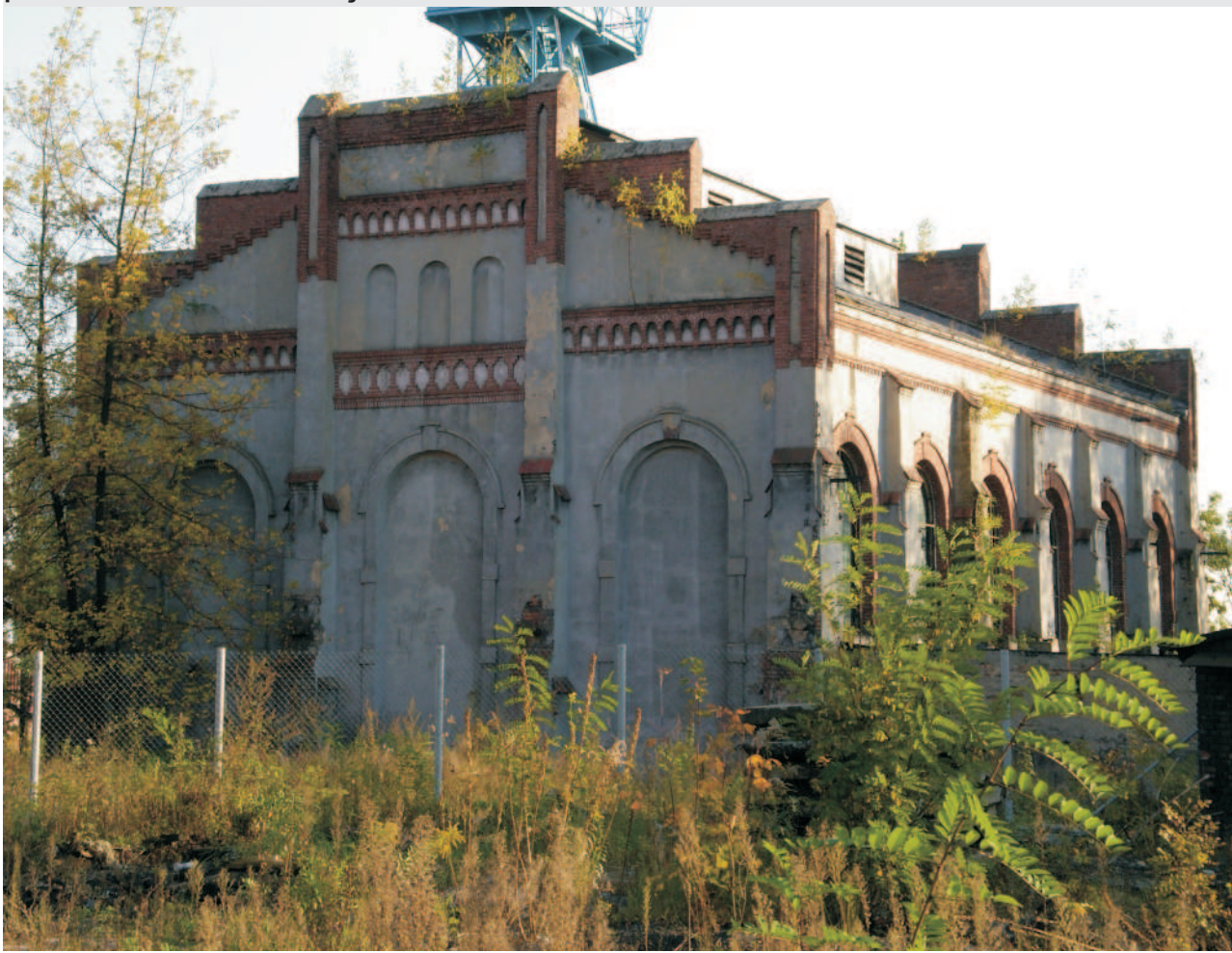
3. Widok obiektu od strony północno-zachodniej
