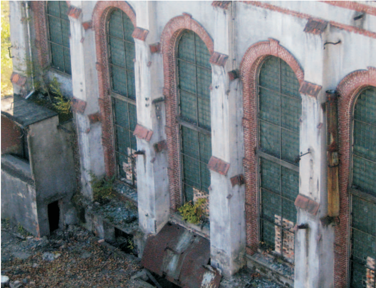
8. Elewacja wschodnia - widok fragmentu
