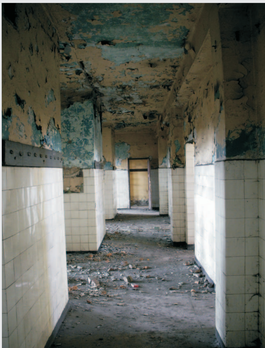
13. Widok korytarza pomiędzy pomieszczeniami sanitarnymi
