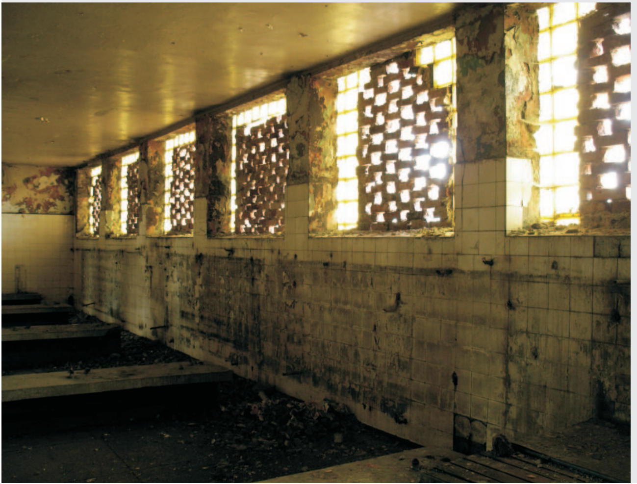
15. Widok pomieszczenia u m y w a l n i
