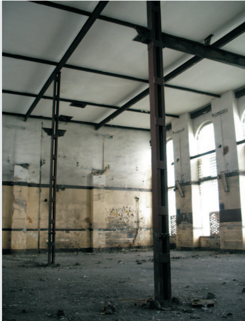
10. Widok głównego pomieszczenia
