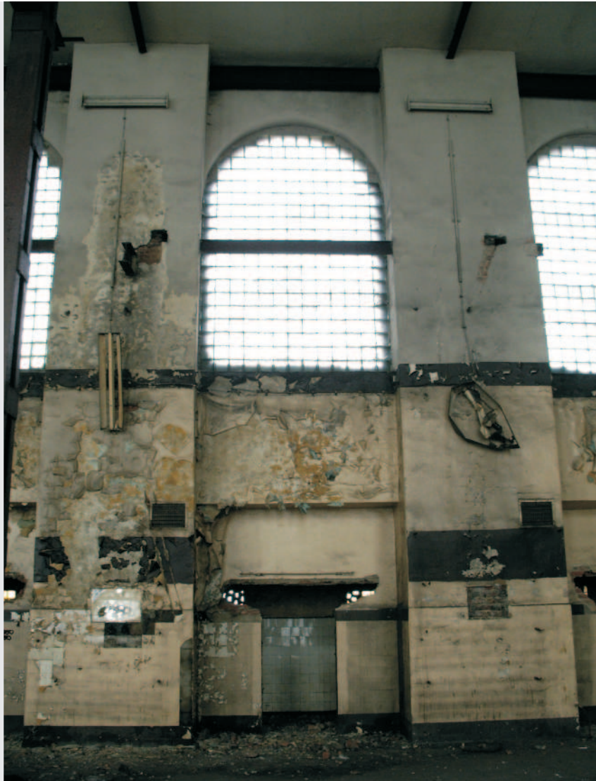
12. Widok głównego pomieszczenia
