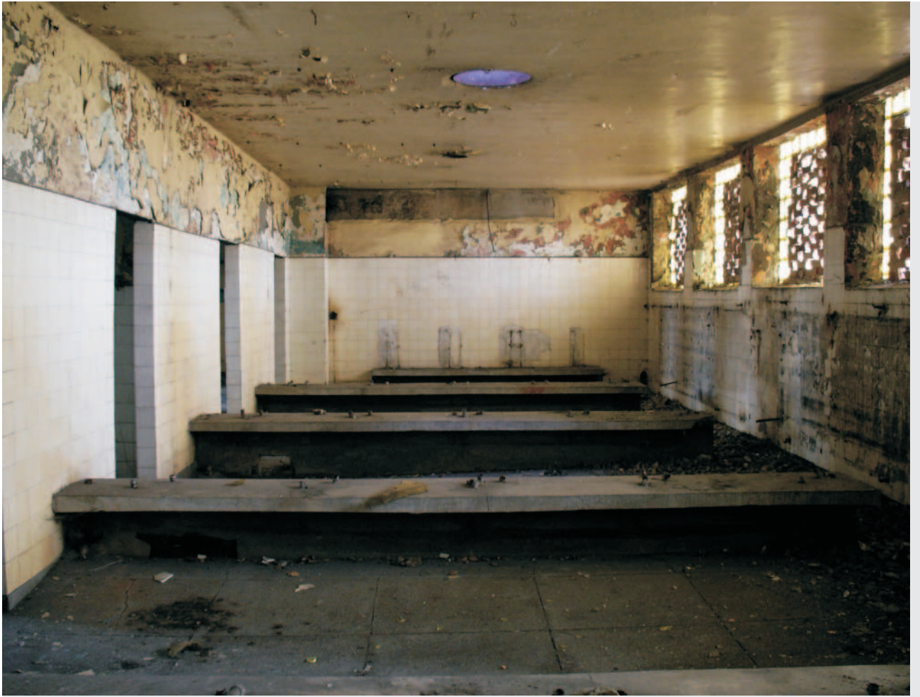
14. Widok pomieszczenia u m y w a l n i
