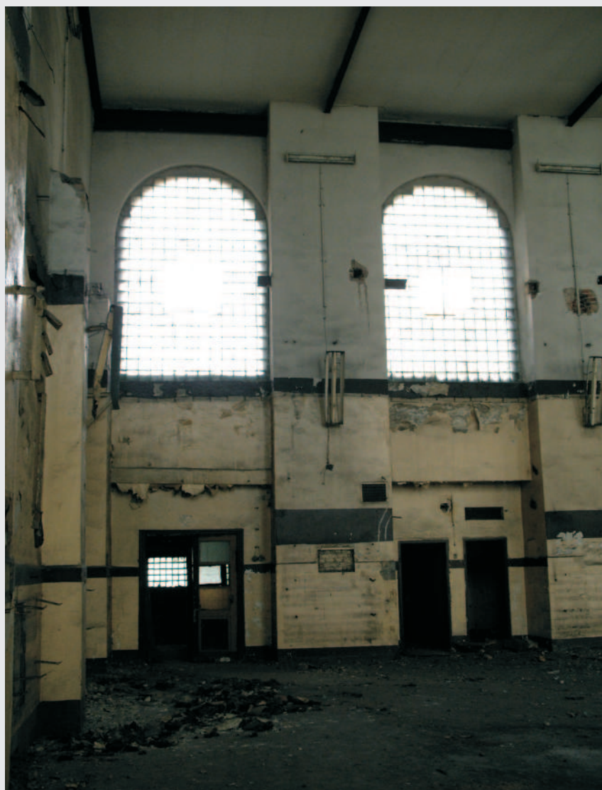
11. Widok głównego pomieszczenia
