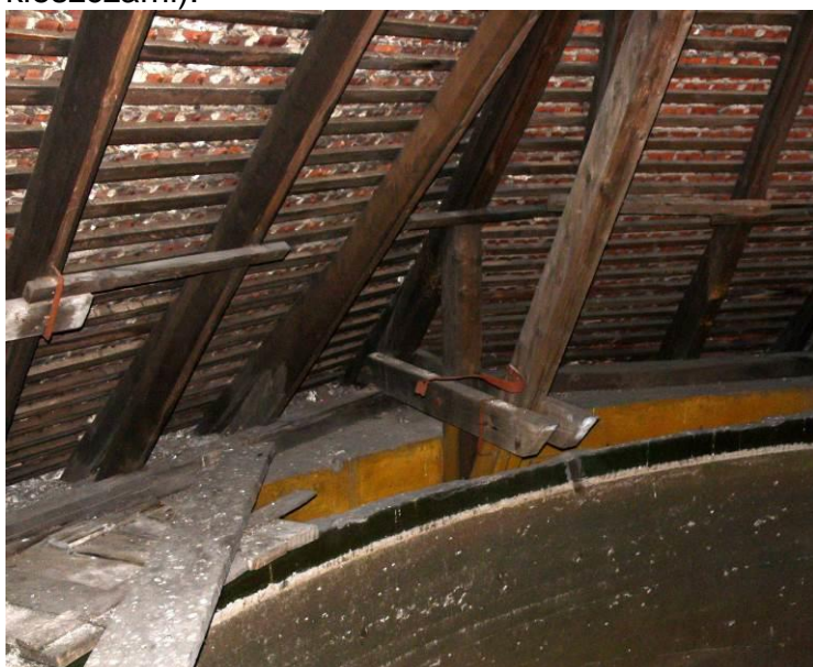
Fot. 5 Konstrukcja dachu: węzeł podporowy (krawężnice i dodatkowe zastrzały połączone kleszczami).
