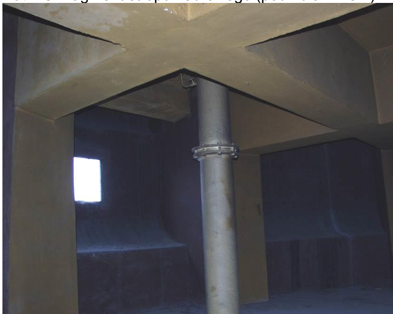
Fot. 10 Fragment stropu żebrowego (pod zbiornikiem) w poziomie +27,00m.
