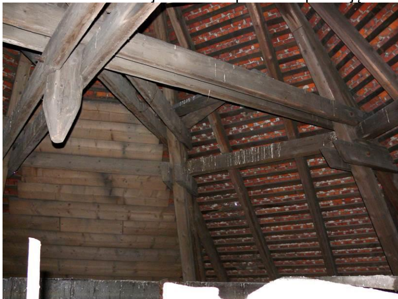
Fot. 4 Konstrukcja dachu: Oparcie słupa na jętkach.
