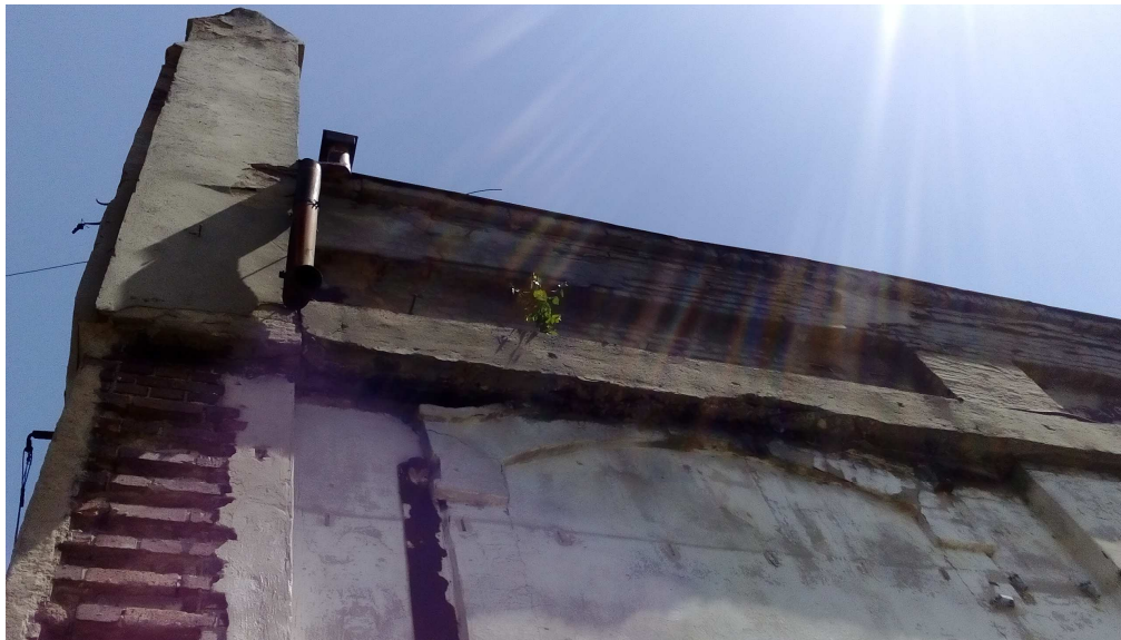
Fot. 29 Miejsce zabudowy rury spustowej.
