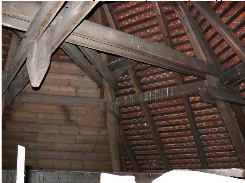
Fot. 4 Konstrukcja dachu: Oparcie słupa na jętkach.
