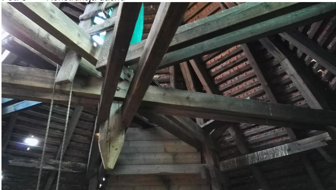
Fot. 5 Konstrukcja dachu
