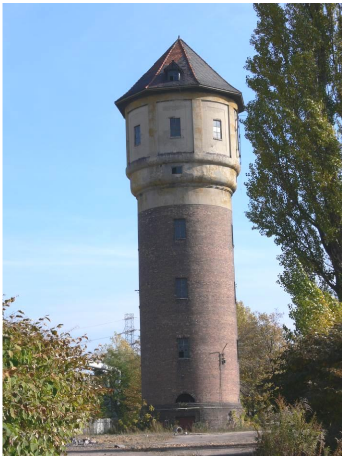
Fot. 1 Widok wieży ciśnień od strony południowo – zachodniej.
