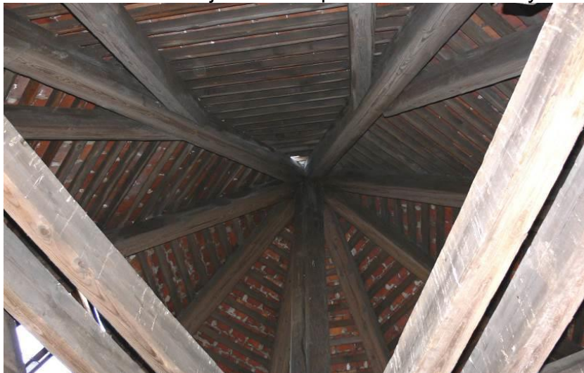
Fot. 3 Konstrukcja dachu: oparcie krokwi narożnych na słupie ośmiokątnym.
